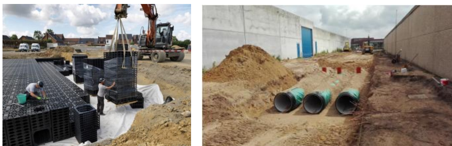
Figuur 7-8 : Voorbeelden van ondergrondse infiltratie met kratten (links; bron: Pidpa) en infiltratieleidingen (rechts; bron: Vlario, 2017)
