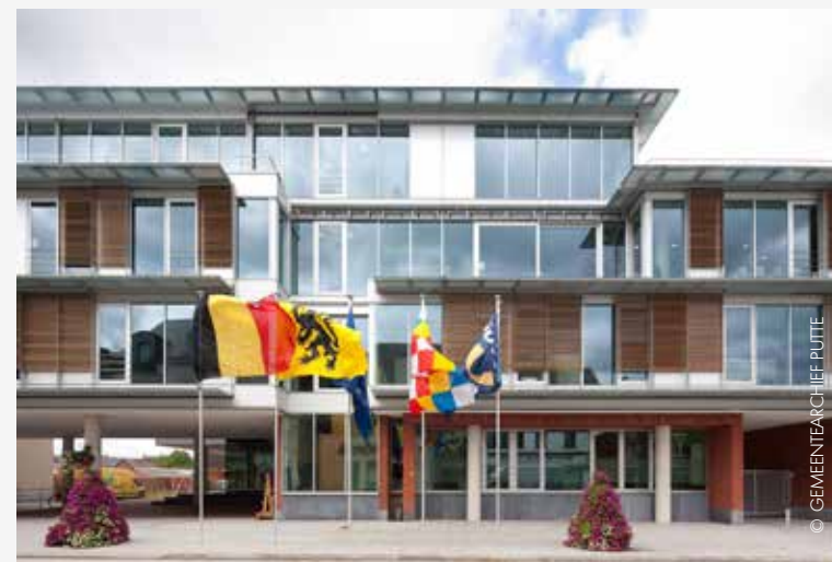
Het Nieuwe Administratieve Centrum.
