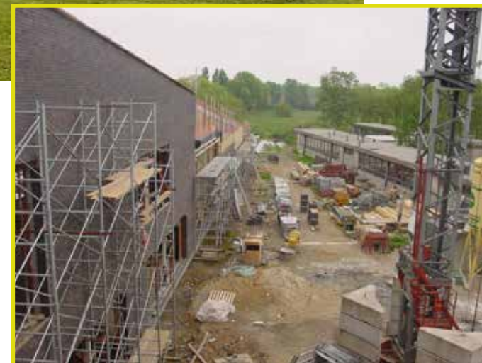
Bouw van het nieuwe gemeentehuis in mei 2002.
